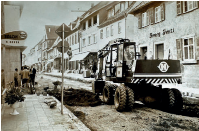
Der Straßen- und Kanalbau in der Kellereistraße in Königshofen in den 1960/1970er Jahren. Foto: Archiv Hanns Friedrich
