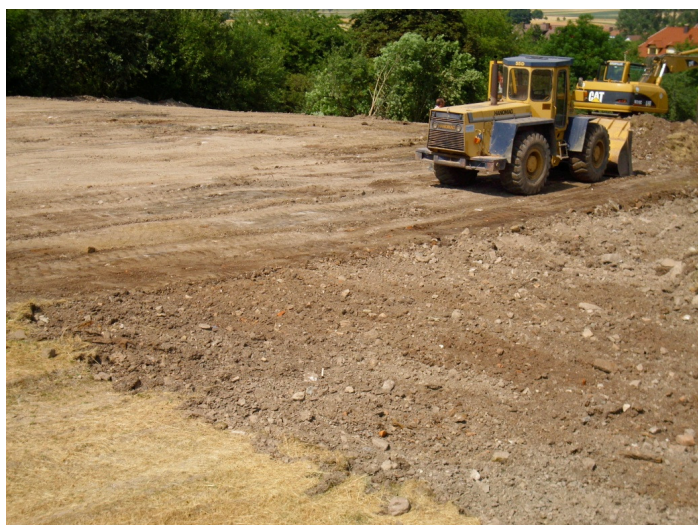
Baggararbeiten an ehemaliger Deponie Althausen
