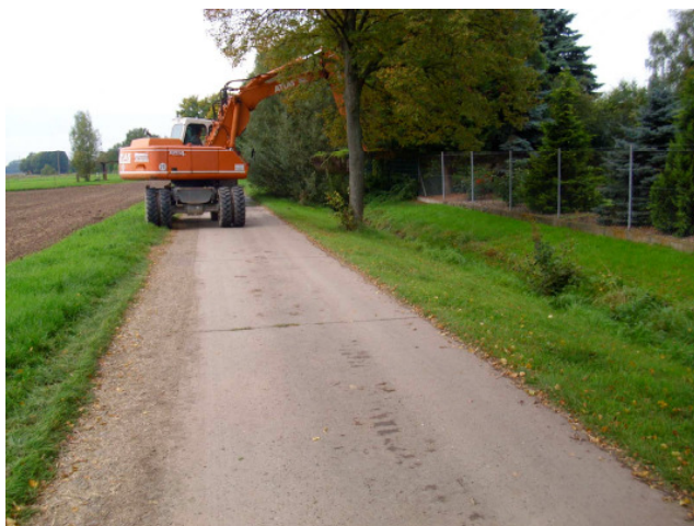
Ausbaggern des Dorfmühlgraben
