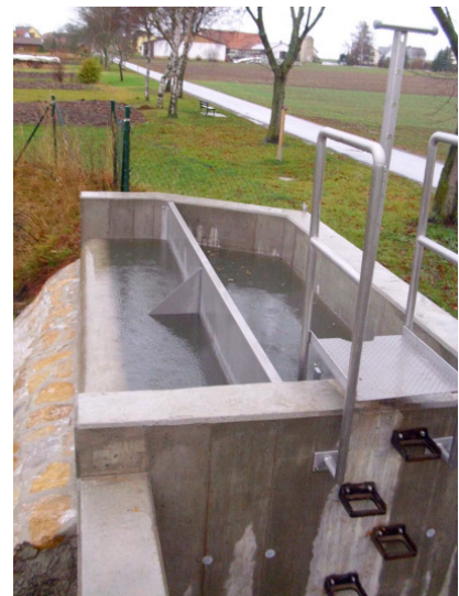
Regenbecken und anspringende Überlaufschwelle am Stauraumkanal Merkershausen
