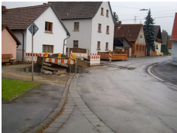
HA-Erneuerung in Gabolshausen, Torstraße
