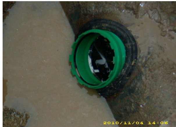
Neue Anbohrung auf bestehendem Kanalrohr
