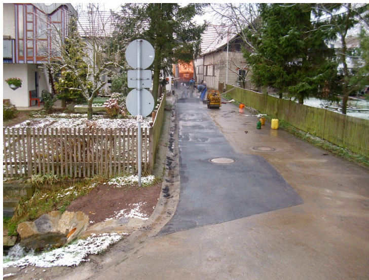
Eyershausen: Regen- u. Fremdwasserkanal „Mittlere Gasse“
