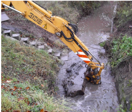
Ausbaggern und Spülen des Aubachs
