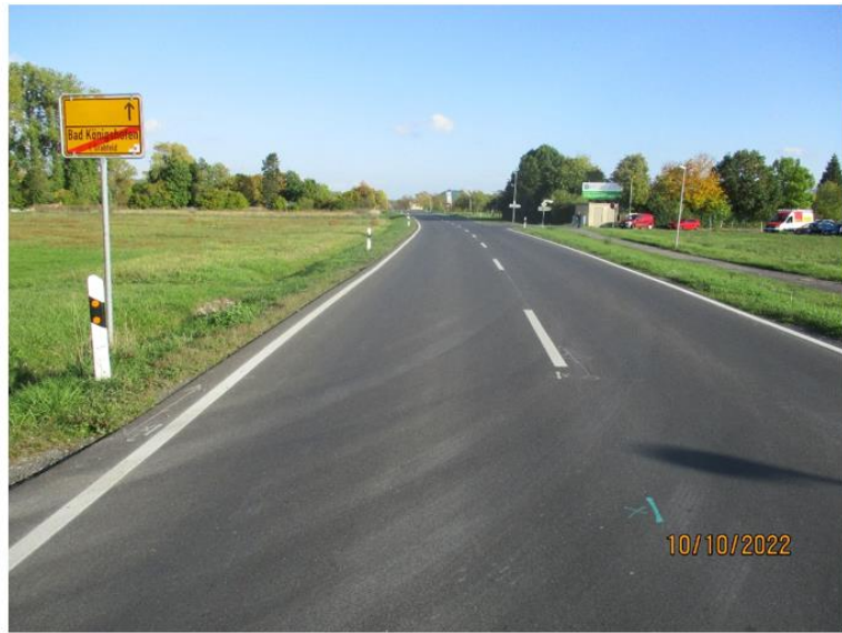
Einbau der neuen Asphaltdecke am 02. Juni 2022
