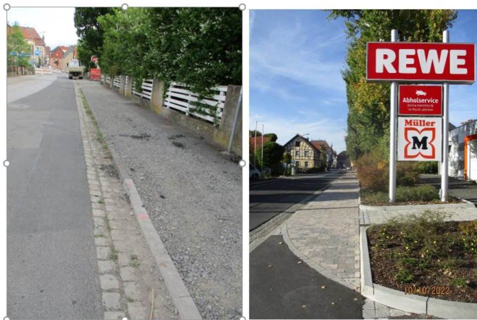
Blick auf den Gehsteig vorab und nach der Fertigstellung mit Muschelkalk-Pflaster
