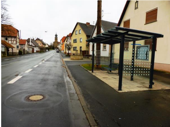
Neues Buswartehäuschen in Eyershausen
