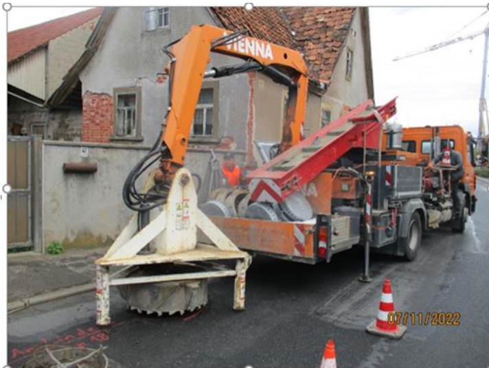
Beispiel: Austausch von Kanaldeckeln in der Ortsdurchfahrt von Eyershausen, St 2282
