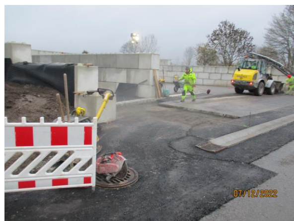
und während des Umbaus
