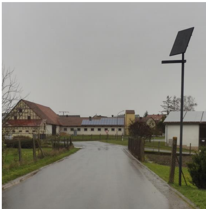
Errichtung einer Solar-Straßenlampe in Merkershausen
