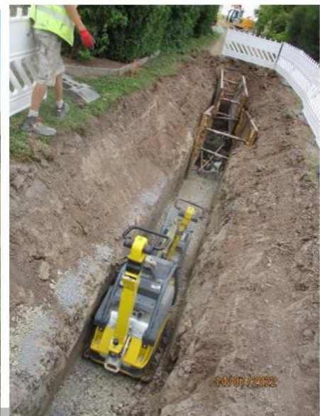
Der Bauplatz „Am Point 1“ wurde durch Verlegung eines Abwasserkanal erschlossen.
