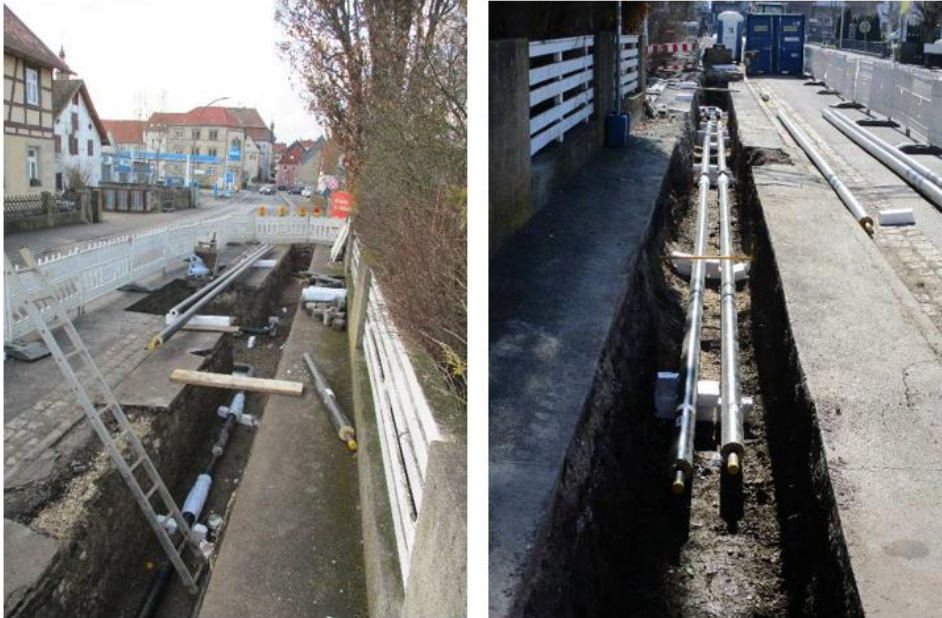
Einbau der Wärmeleitungen in den Gehsteig „Bamberger Straße“
