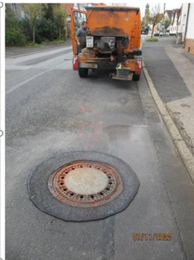
Beispiel: Austausch von Kanaldeckeln in der Ortsdurchfahrt von Eyershausen, St 2282
