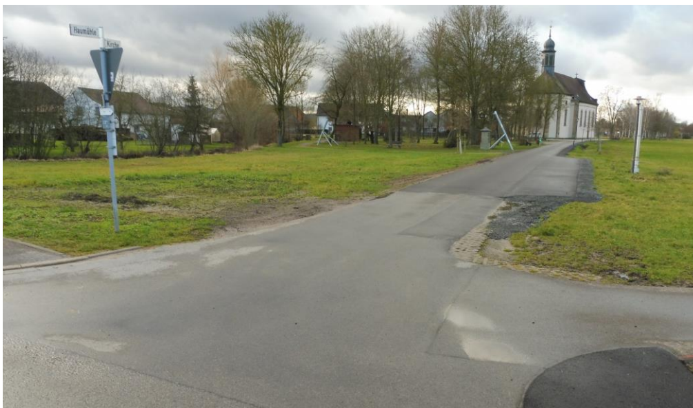
Aufbringen einer neuen Deckschicht bei der Zufahrtsstraße „Ipthausen–Kirche“
