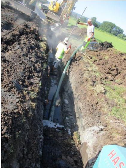
Verlängerung der Abwasserdruckleitung im Bereich Ipthausen-Kirche
