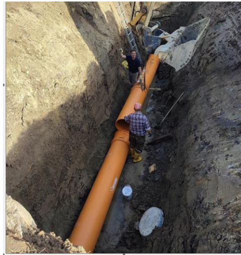
Einbau einer neuen Kunststoffleitung
