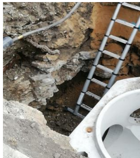
Blick auf die Kanalbaustelle „Herbstädter Str.“ und auf den Rohrgraben im Bereich-Gips-Fels
