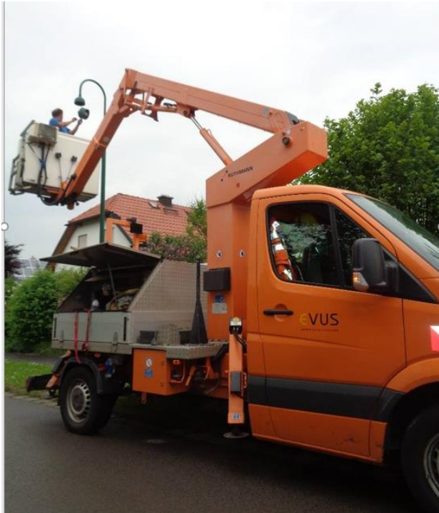
Umrüstung auf LED-Leuchtmittel
