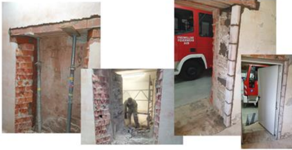
Durchbrüche Wand Feuerwehr und Wand Alte Schule
