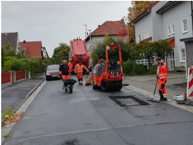
Reparatur Schlaglöcher/Schadstellen (Martin-Luther-Str.) sowie Gehwegabschnitte
