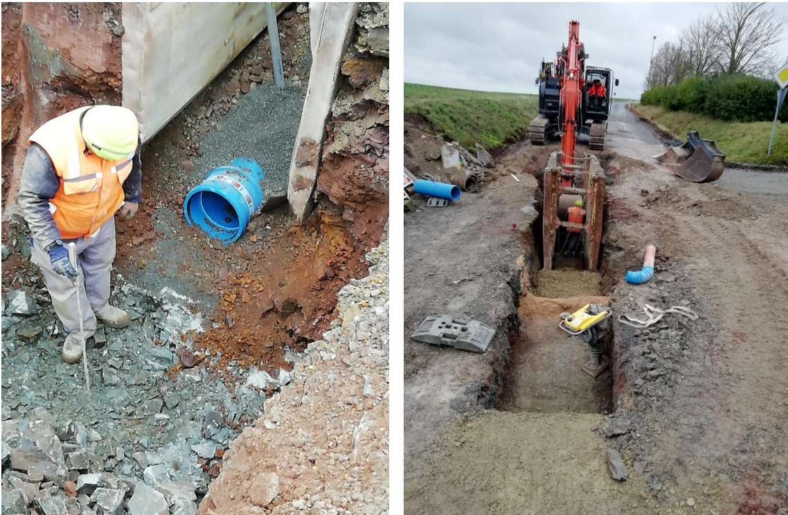
Teilabschnitt 2: Kanal- und Straßenbau oben „Am Haag“: massiver Fels
