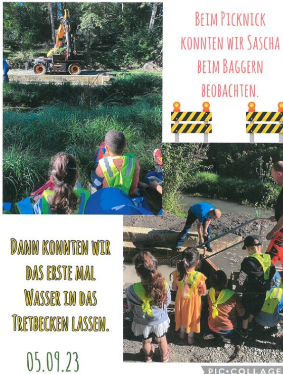
Bau des Wasser-Tretbeckens im Klostergarten
