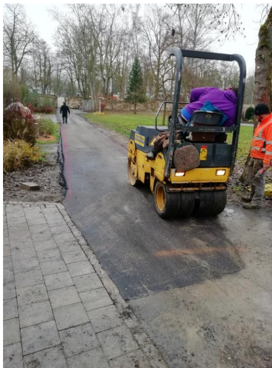
Fußweg Klostergarten nach Einbau Wärmeleitung
