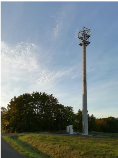
Der Funkmast wurde im August errichtet.
