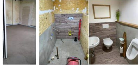
Einbau Estrich Schmiede Sanierung WC Alte Schule
