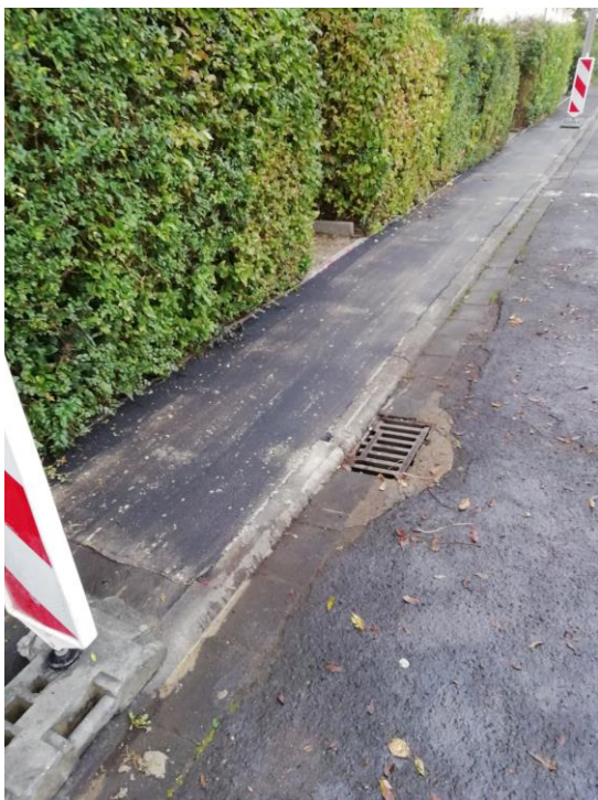
Erneuerte Gehweg-Asphaltdecke (Keßlerstr.)
