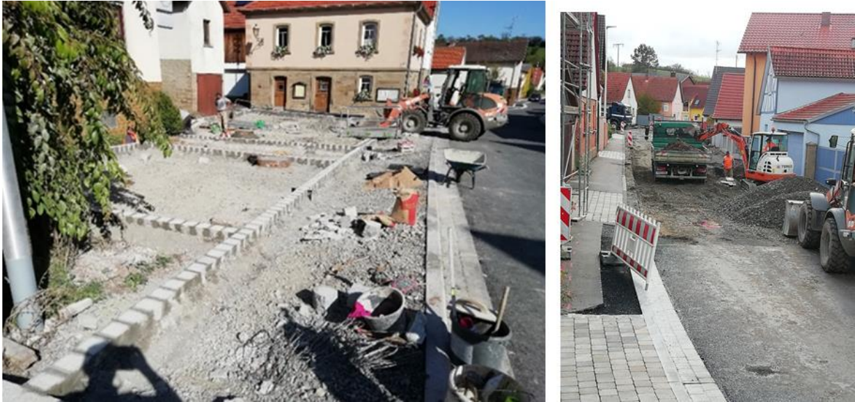
Einbau von Granit-Einzelern am neuen Dorfplatz und Aufschotterung am 2. Bauabschnitt
