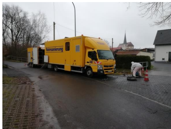
Blick auf den LKW der Schachtsanierungen
