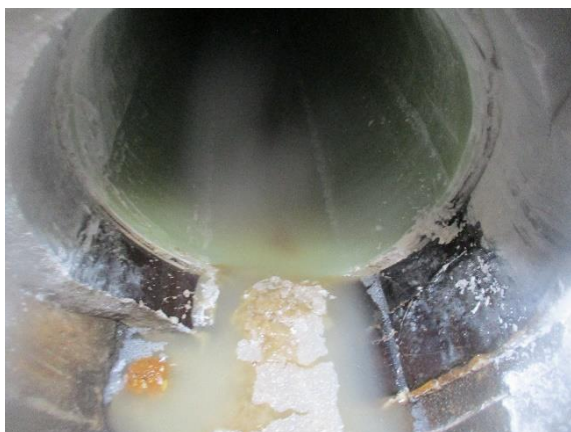
Das Ende des Inliners im DN 400 Rohr
