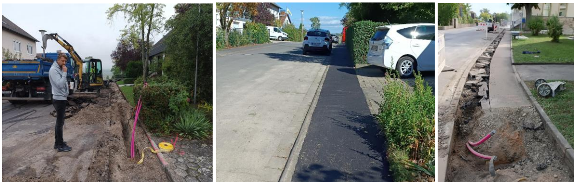
Verkabelung: Firma aus Litauen: Am Hopfengarten mit Gehwegerneuerung und in der Festungstraße
