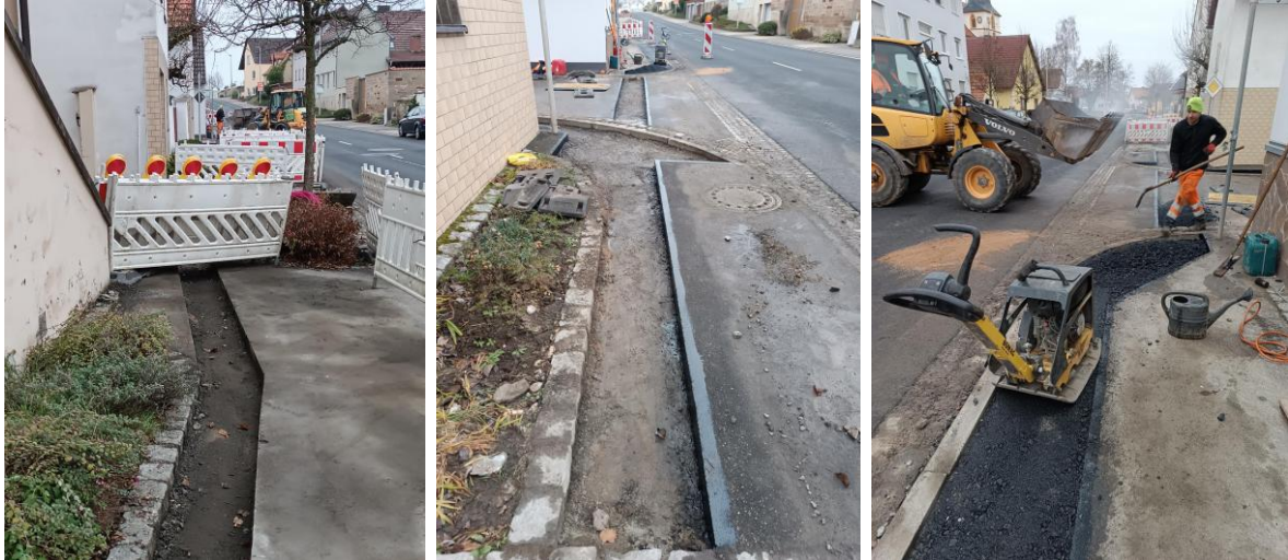
Dt. Telekom: Glasfasereinbau im Stadtteil Untereißfeld
