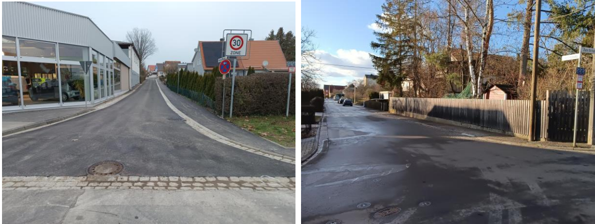
Blick auf die fertiggestellte Maßbergstraße und auf den Siedlungsweg
