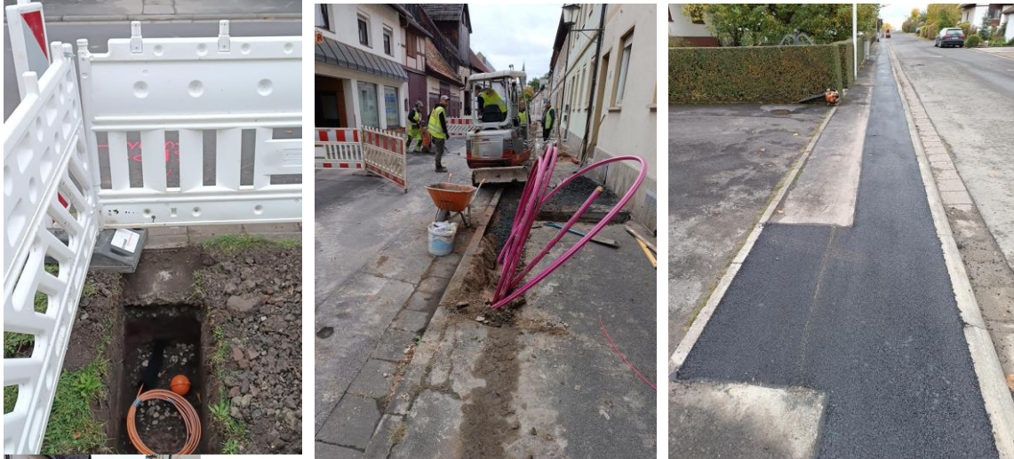
Hausanschluss mit Marker, Verkabelung: Kellereistraße, An der Gipsmühle
