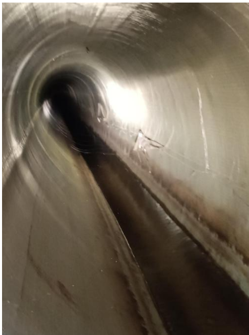
Blick in den GFK-Inliner in Untereißfeld (Ei-Profil) und im Kanalschacht: Blick auf den Liner-Anfang
