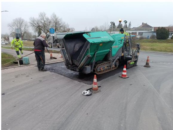
Asphaltreparaturen in der Straße Am Bahnhof
