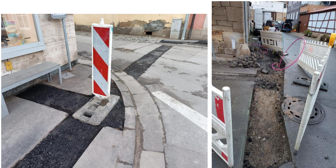
Aufgrabungen und Querungen in Altstadtbereich von Bad Königshofen
