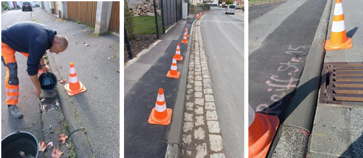
Sanierung von einzelnen maroden Rinnensteinen und Betonbordsteinen
