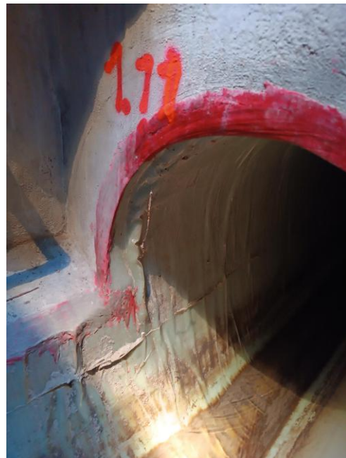
Blick in den GFK-Inliner in Untereißfeld (Ei-Profil) und im Kanalschacht: Blick auf den Liner-Anfang
