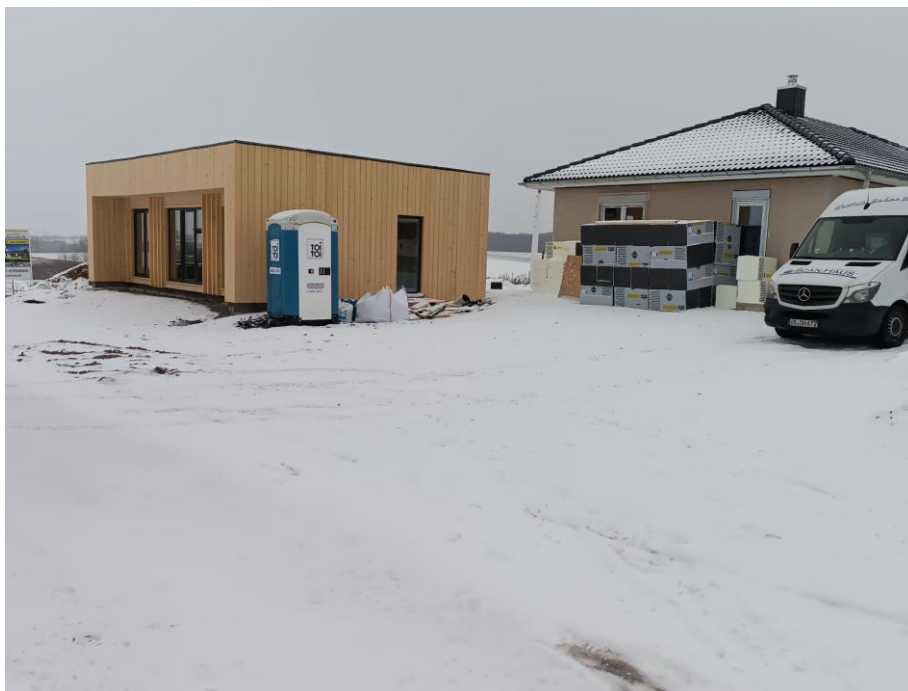
Errichtung des ersten Wohnhauses am Oberen Schmalgarten 1a
