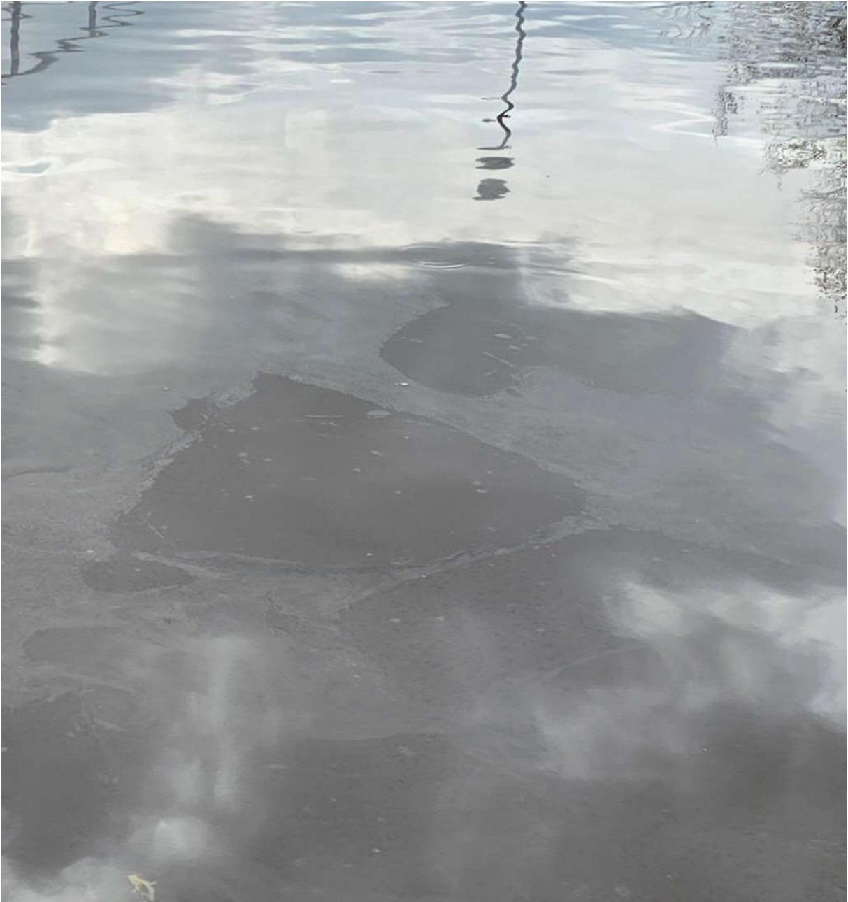
Bild Polizei: Ölschlieren auf einem der beiden Absetzbecken des Klärwerkes Bad Königshofen
